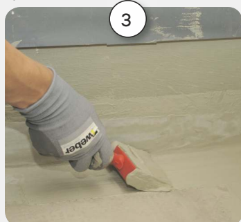
Pēc auduma uzklāšanas tam tiek uzklāta svaiga hidroizolācijas masas kārtā
