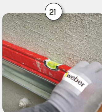
Flīzējuma apakšējās malas līmeņošana
