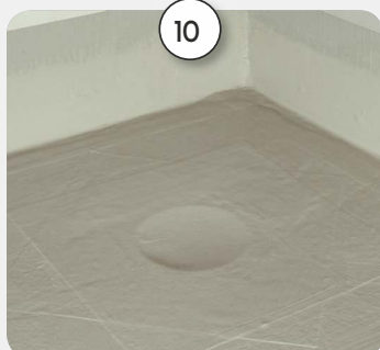
Kārtīgi no mitruma izolēts traps
