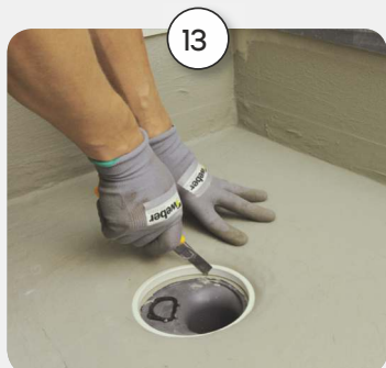
Spriegojuma riņķa uzstādīšana
