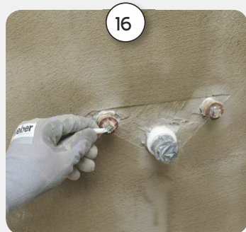
Pievadiem nepieciešamā izmēra armēšanas stiklašķiedras sieta nomērīšana
