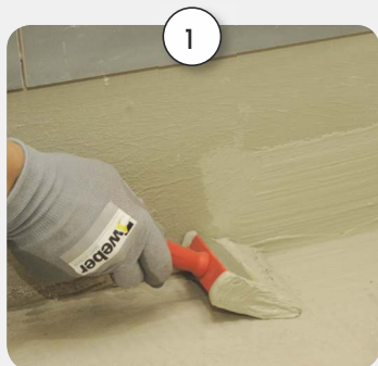
Hidroizolācijas ieklāšana zem šķiedras auduma
