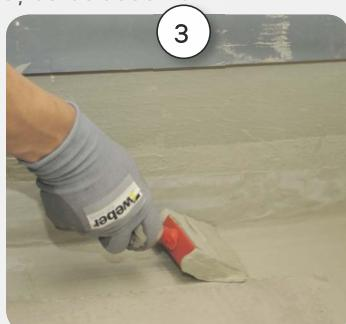
Pēc auduma uzklāšanas tam tiek uzklāta svaiga hidroizolācijas masas kārtā
