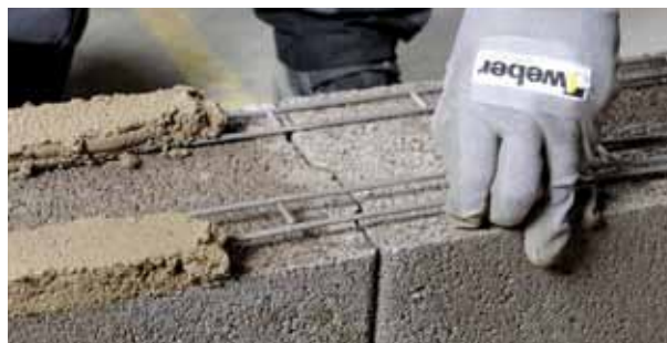
Fibo Efekt ārsienu bloku iestrāde
