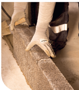
Pirmās rindas kārtojumu vienmēr sāk no stūra ar pilnu, nepiegrieztu bloku
