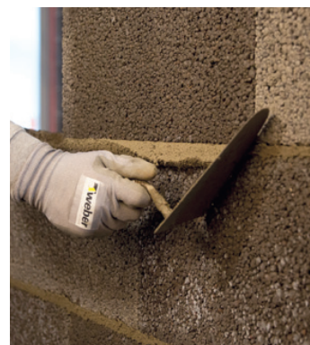
Blokus mūrē ar pilnu horizontālo šuvi
