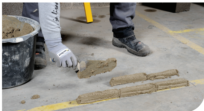
Blokus mūrē ar dalīto horizontālo šuvi: 2/3 java + 1/3 gaiss
