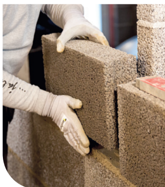
Blokus mūrē ar pilnu horizontālo šuvi
