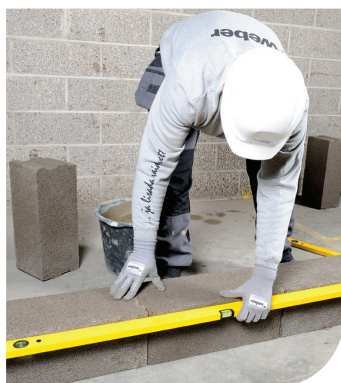
Pirmās rindas kārtojumu vienmēr sāk no stūra ar pilnu, nepiegrieztu bloku
