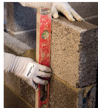
Standarta durvju aili uzmūrē ar precīzi 8 pilnu bloku rindām
