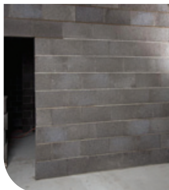
Standarta durvju aili uzmūrē ar precīzi 8 pilnu bloku rindām
