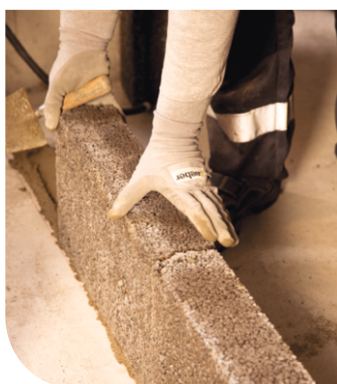
Pirmās rindas kārtojumu vienmēr sāk no stūra ar pilnu, nepiegrieztu bloku
