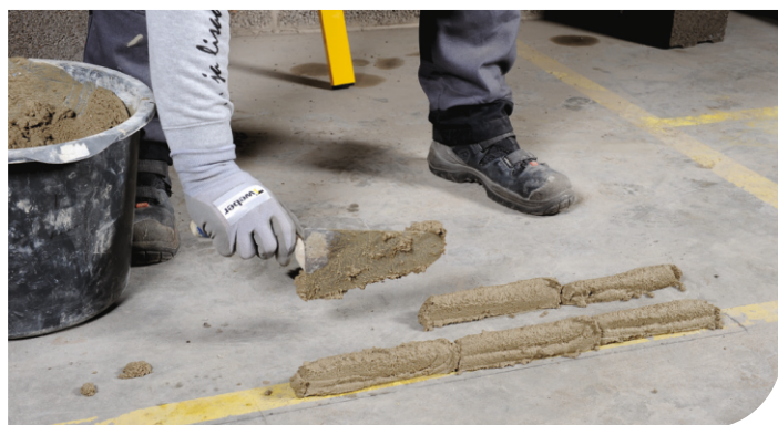
Blokus mūrē ar daļīto horizontālo šuvi: 2/3 java + 1/3 gaiss
