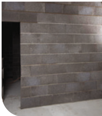
Standarta durvju aili uzmūrē ar precīzi 8 pilnu bloku rindām
