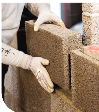
Blokus mūrē ar pilnu horizontālo šuvi
