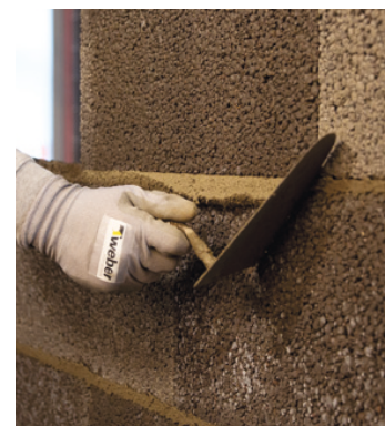
Blokus mūrē ar pilnu horizontālo šuvi
