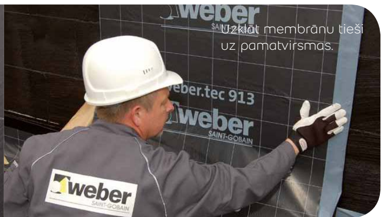
Ar rulli noņemt arī zem membrānas palikušos gaisa burbulus.
