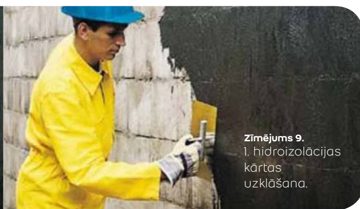
Zīmējums 8. Uzklāt virsmai, stingri piespiežot masas 1. kārtu.
