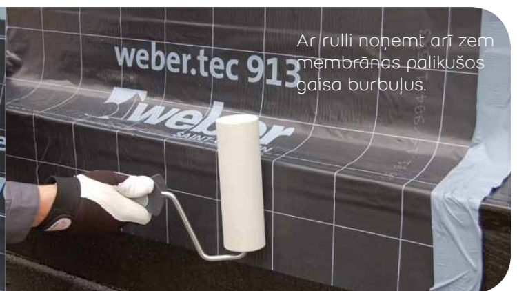
Izmantot rulli, lai piestiprinātu membrānu pie pamatvirsmas.
